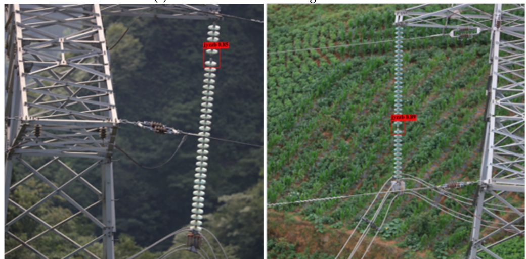
(d) Insulator tie wire loosening test results
