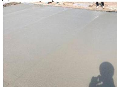
(d) The effect of the surface layer after manual smearing
