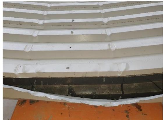
(d) Flexure cracks
