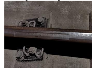
(d) Rail corrugation on the straight line
