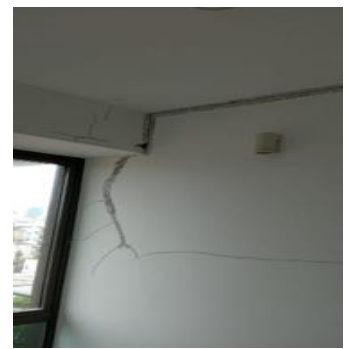
(d) Internal wall crack
