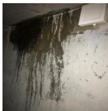
(d) Efflorescence
