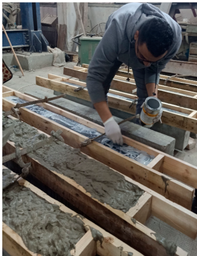
(d) Application of the ECC layer
