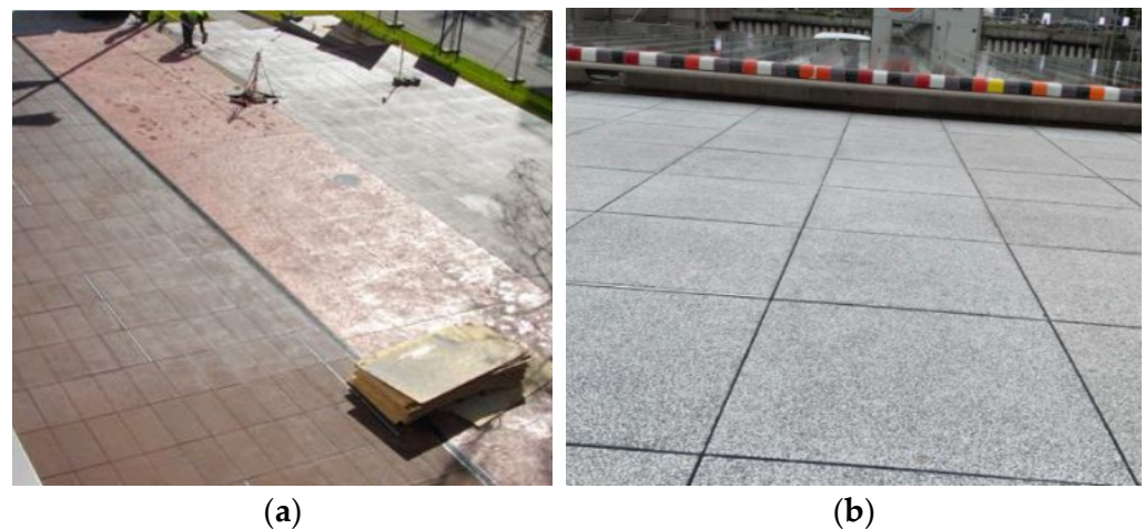
Figure 33. (a) GFRC pavement [135]; (b) GFRC pavement on La Défense, Paris, France [136].
