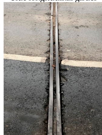
(d) Perishing of rubber sealing belt
