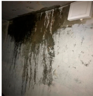
(d) Efflorescence
